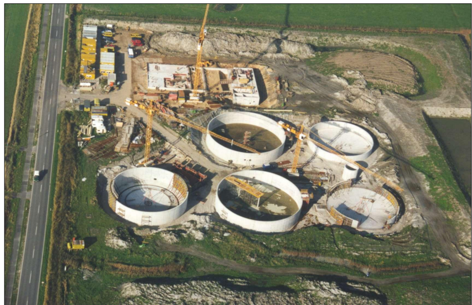
Bau der Belebungs- und Nachklärbecken
