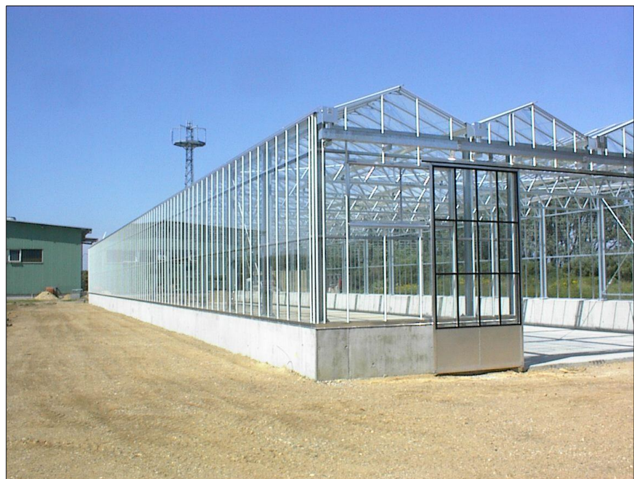
Trocknungshalle in der Bauphase
