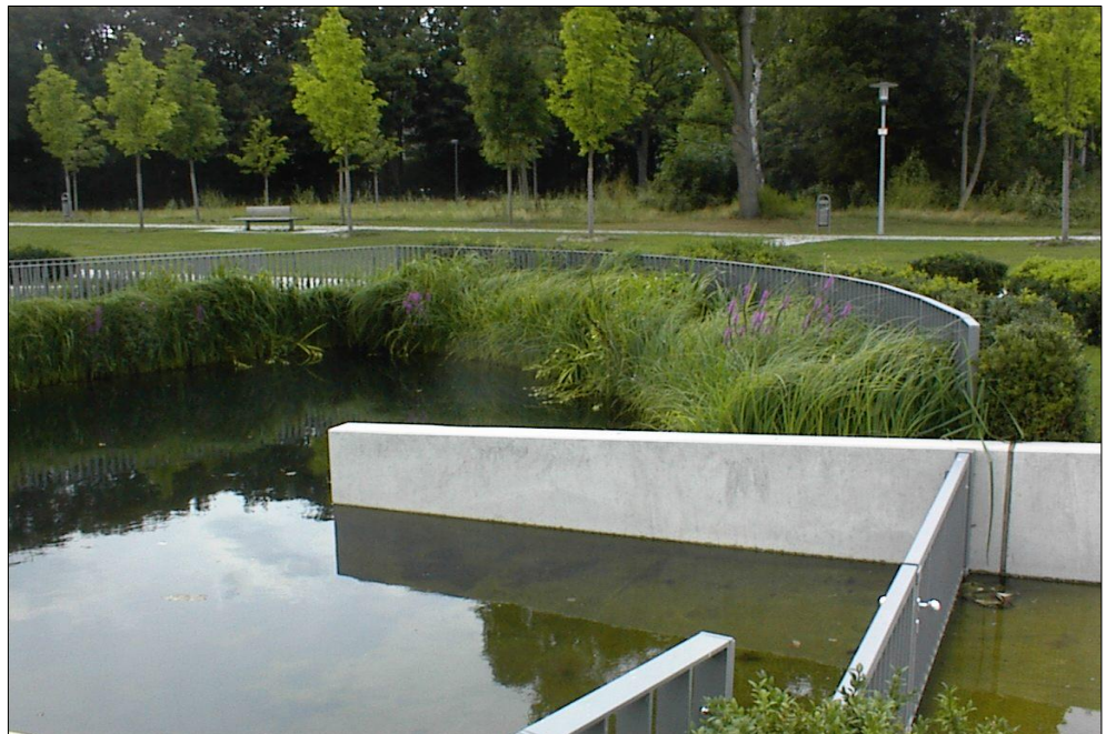
Becken der Regenwasserbehandlung in der Parkanlage
