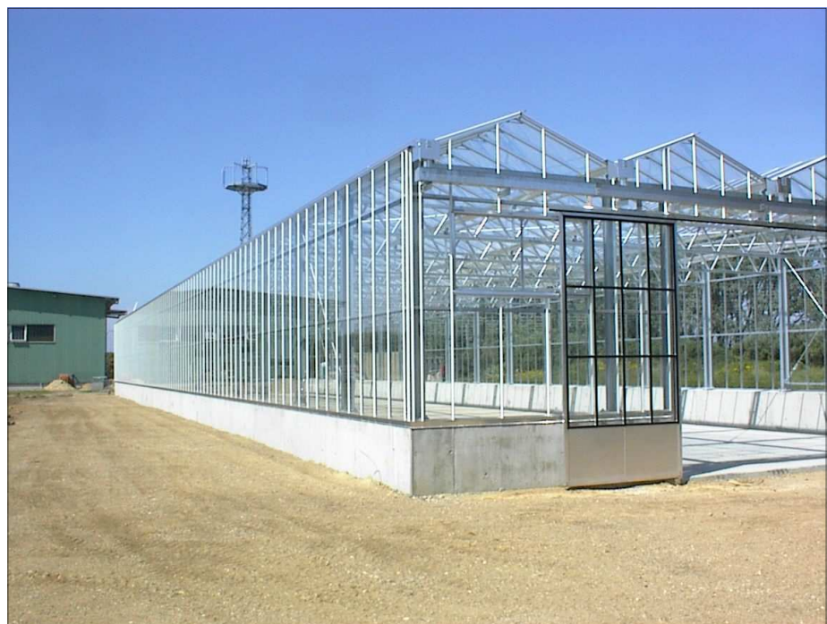
Trocknungshalle in der Bauphase
