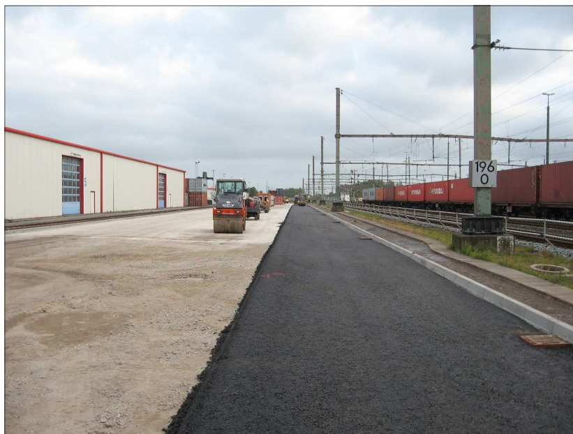
Einbau der bituminösen Tragschicht
