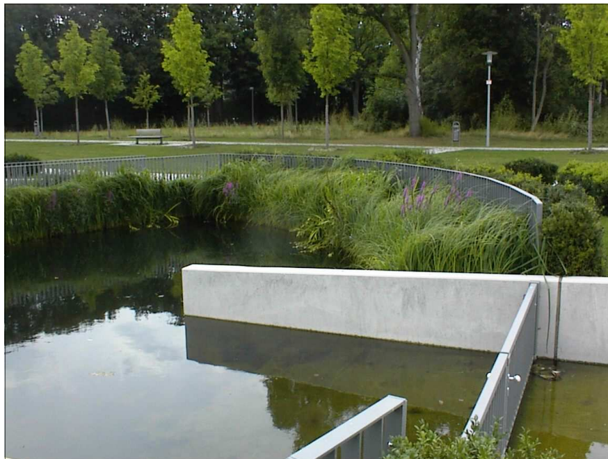
Becken der Regenwasserbehandlung in der Parkanlage
