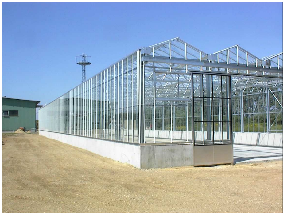
Trocknungshalle in der Bauphase
