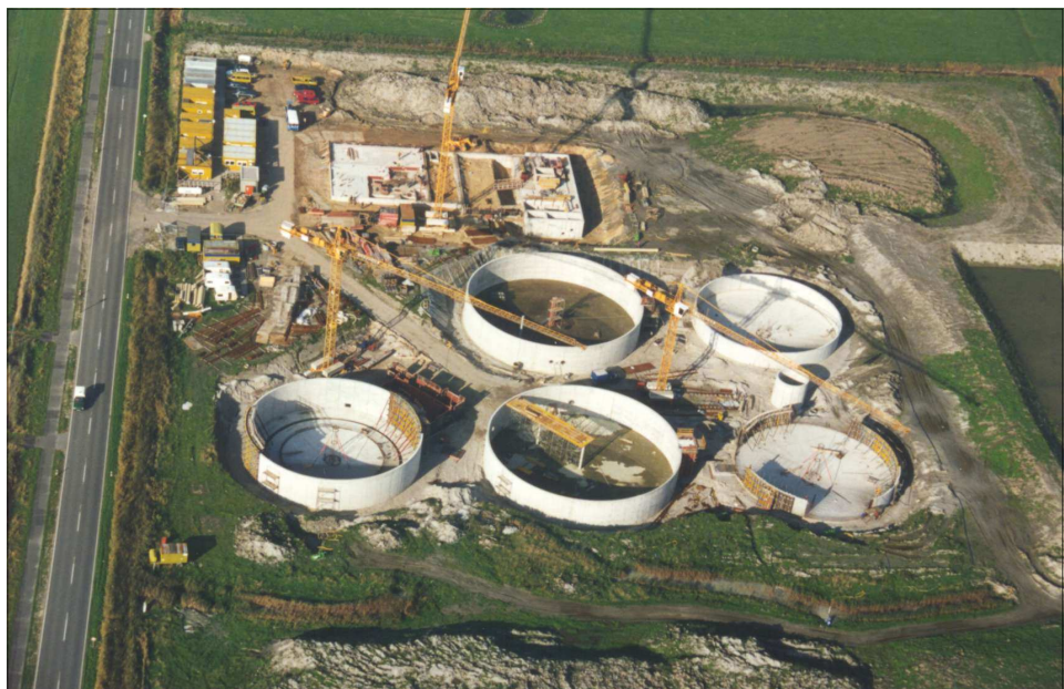
Bau der Belebungs- und Nachklärbecken
