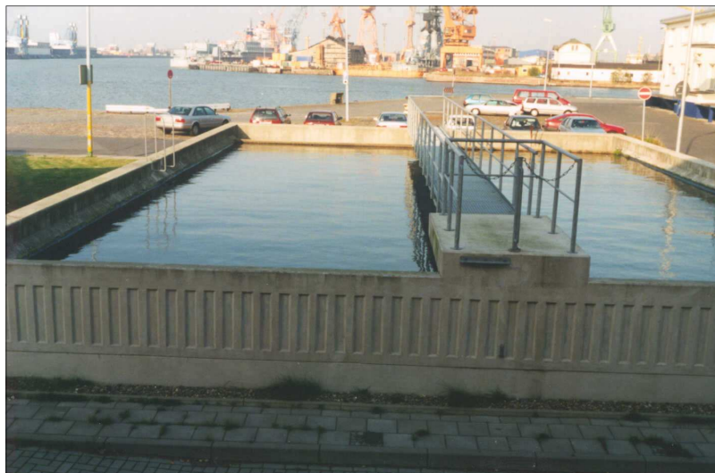
Behandlungsanlage als ständig gefülltes Becken
